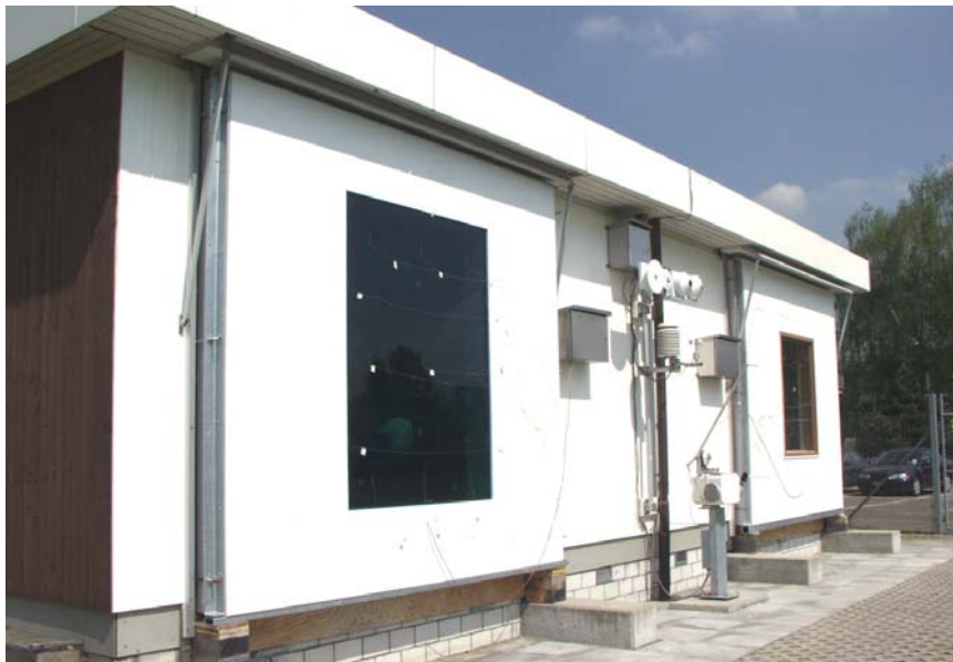
Abbildung 1: Solarprüfstand der EMPA für die Untersuchung von solaren und thermischen Eigenschaften transparenter Fassadenbauteile. Zwischen den Testflächen ist die Klimadatenerfassung mit einem elektronisch nachgeführten Direktstrahlungssensor platziert.
