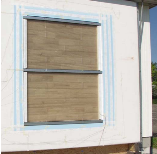
Abbildung 26: Holzrahmenkonstruktion mit verglastem Lamellenabsorber. Die Dicke der Wärmedämmung (rechts) ist in Wirklichkeit wesentlich grösser als die Breite der Holzlamellen.
