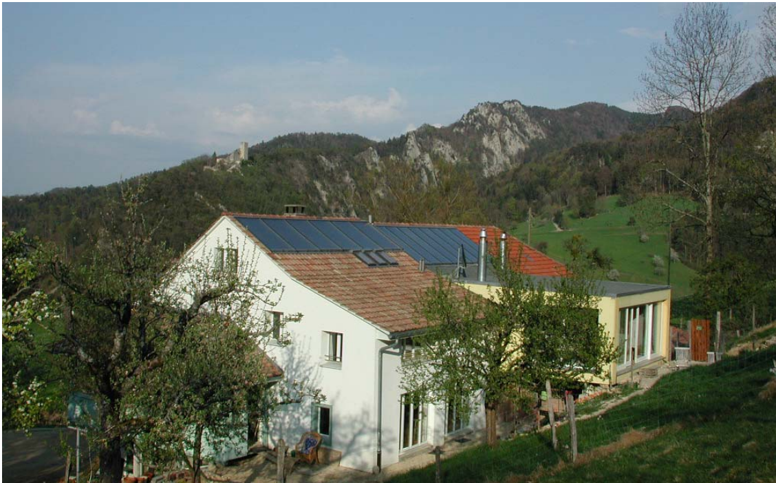
Abb. 3.1 Die zwei Kollektorfelder mit einer Gesamtfläche von 33.3 m 2 auf dem renovierten Bauernhaus.
