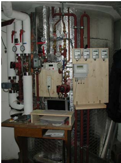
Abb. 3.2 Armaturen, Pumpe und Wärmezähler
