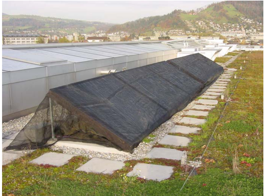
Bild 10: Die grosse Kollektoranlage in Thun mit der ganzflächigen Netzabdeckung.
