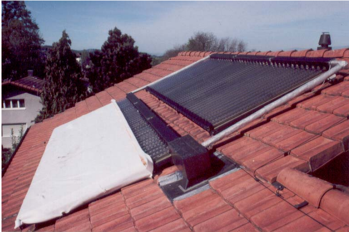
Bild 4: Teilabdeckung des Kollektorfeldes der Anlage Rüti mit einem weissen Vlies, das im Strassenbau eingesetzt wird.
