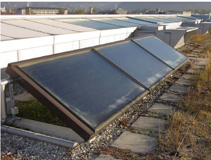
Bild 31: Das kleine Kollektorfeld der Anlage Thun am 27. Oktober morgens um etwa 8 Uhr: Am unteren Kollektorrand sind noch Reste von Raureif sichtbar (ca. 4 Minuten vorher war der ganze Kollektor bedeckt). Die zum Zeitpunkt der Aufnahme sichtbare noch verbleibende Reif-Fläche nimmt von links nach rechts zu und lässt damit erkennen, dass die Pumpe in Betrieb ist. (Die Kollektorverrohrung ist nicht nach Tichelmann
