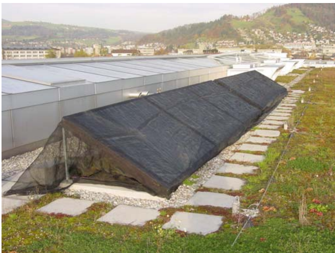
Fig. 2: mit einem Netz komplett abgedecktes Kollektorfeld in Thun, das die Einstrahlung um etwa 30 .. 40% verringert.
