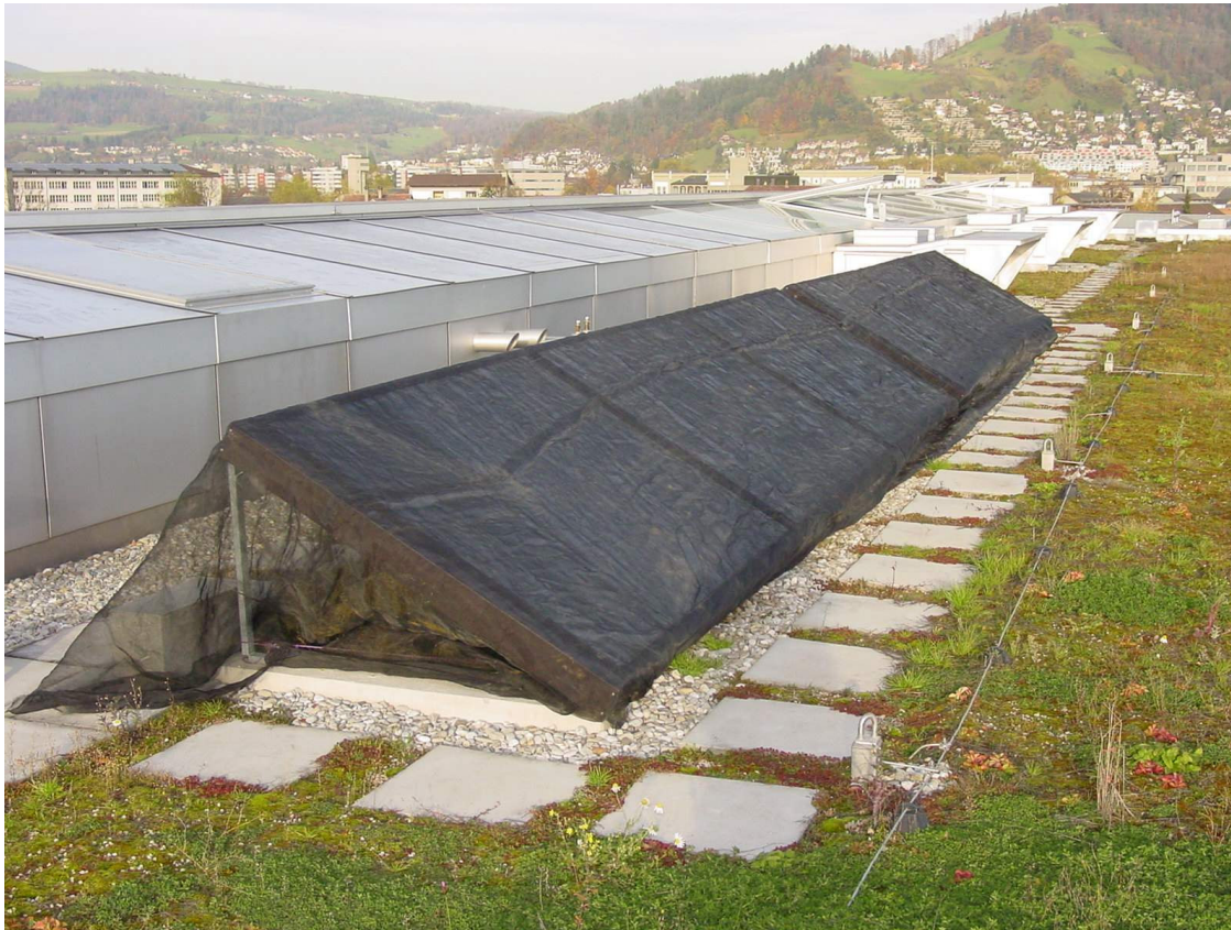
Bild 9: Die Kollektoranlage in Thun mit der ganzflächigen Abdeckung mit einem Netz
