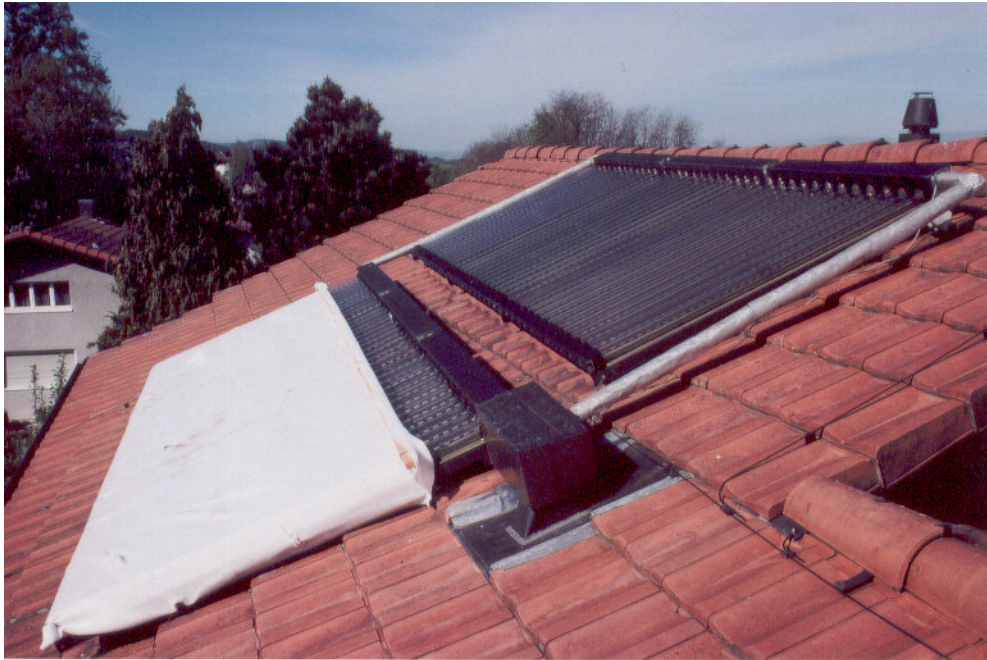
Bild 4: Teilabdeckung des Kollektorfeldes der Anlage Rüti mit einem weissen Geo-Vlies
