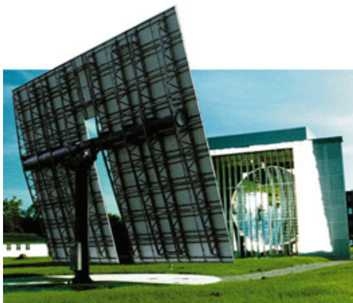
Le four de 40 kW de l'Institut Paul Scherrer (PSI) pour les projets de chimie solaire utilise un miroir plan pivotant et un miroir parabolique fixe pour la concentration du rayonnement solaire. (Photo : PSI)
