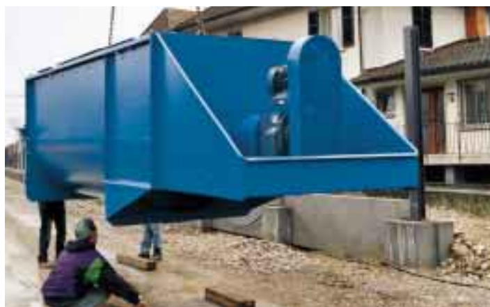
Préparatifs du montage : l'admission d'eau, surmontée du générateur.
