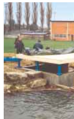
Montage de la vis hydraulique sous forme d'unité compacte dans le Grützbach près de Derendingen (SO).
