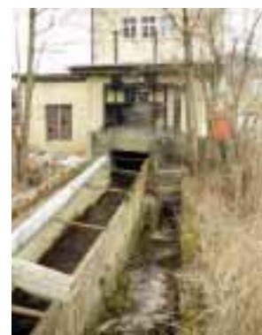
L'eau est acheminée vers la salle des machines (classée monument historique) par le canal d'amenée.
