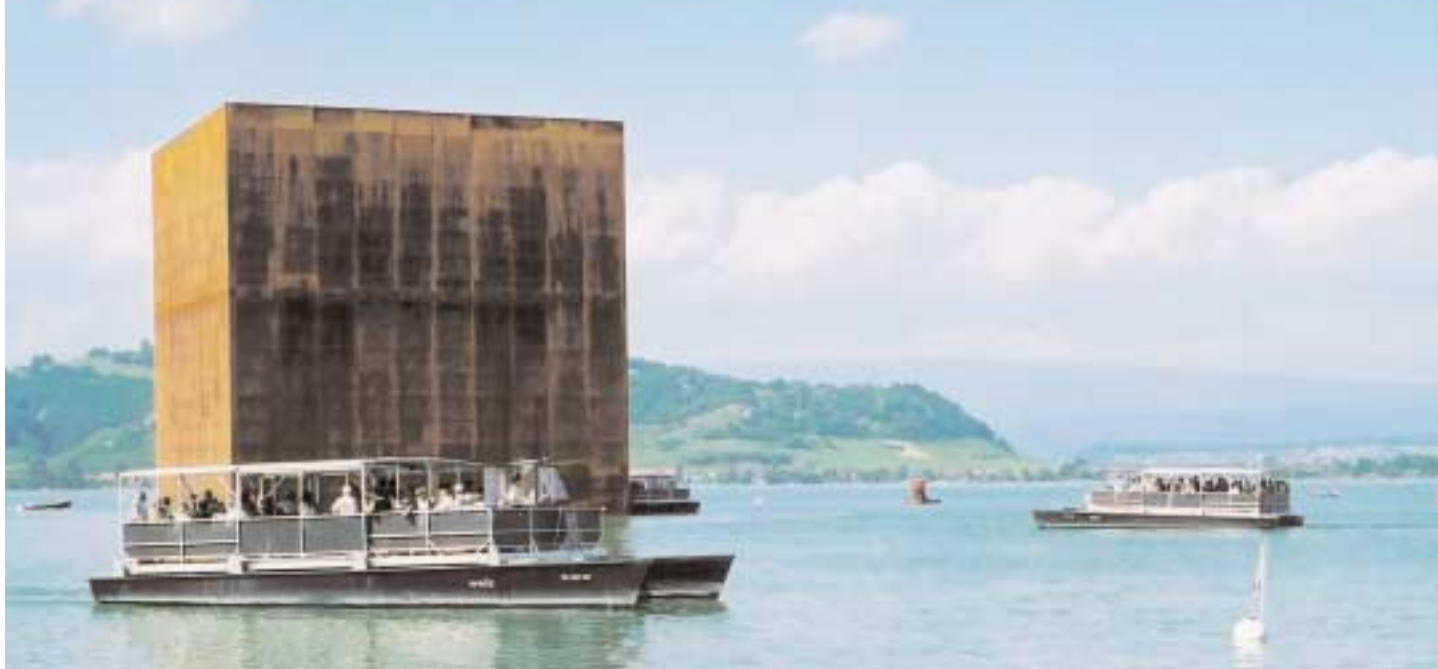
Des bateaux solaires silencieux et sans gaz d'échappement acheminent les visiteurs vers le monolithe du lac de Morat.
