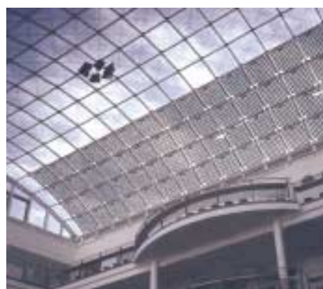
Un exemple d'intégration au bâtiment à l'Université technique de Munich.
