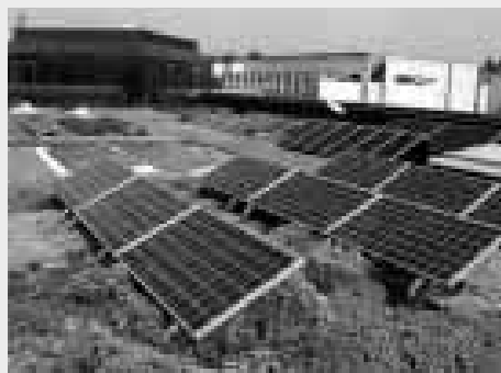
Demosite à l'EPFL : démonstration de différentes variantes d'intégration de modules photovoltaïques, par exemple, sur une toiture plate engazonnée.
