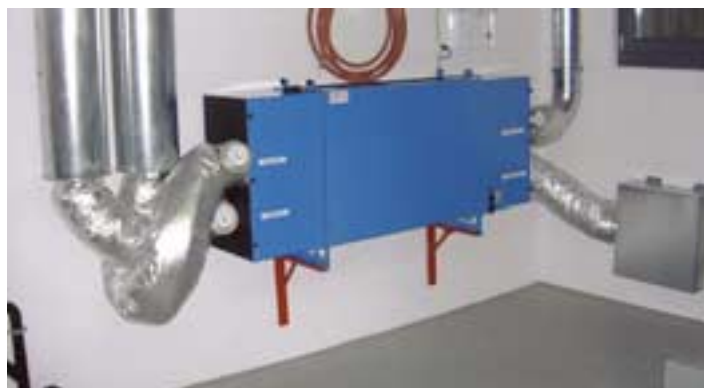
L'échangeur de chaleur est un élément central de la ventilation mécanique douce. C'est essentiellement lui qui décide de l'efficacité énergétique qui pourra être atteinte.
