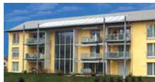
Le préchauffage solaire, une application intéressante pour les immeubles à plusieurs appartements.
