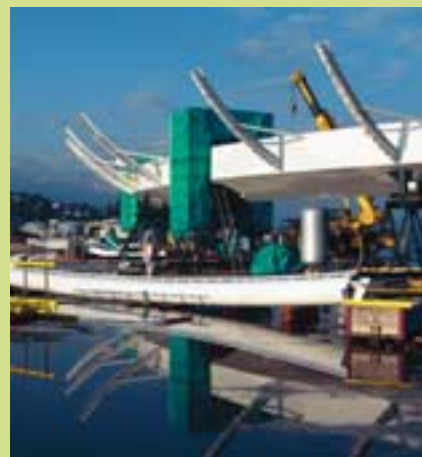
Construction Les Galets, arteplage Neuchâtel. (Photo: Expo.02)
