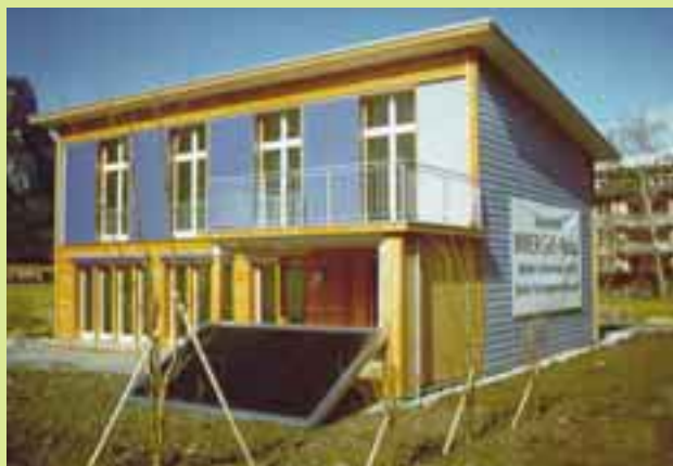
Maison Minergie „Casa-Vita“ à Mollis. Ce standard est appliqué de plus en plus souvent en Suisse. (Photo: SSES)
