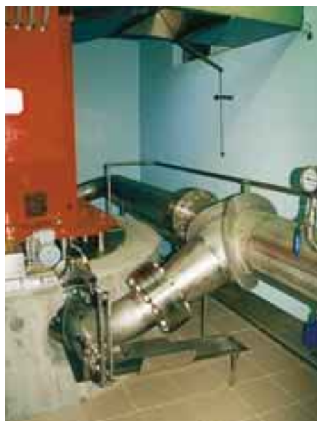
Alimentation des deux injecteurs de la turbine Pelton à axe vertical, en acier inoxydable.
