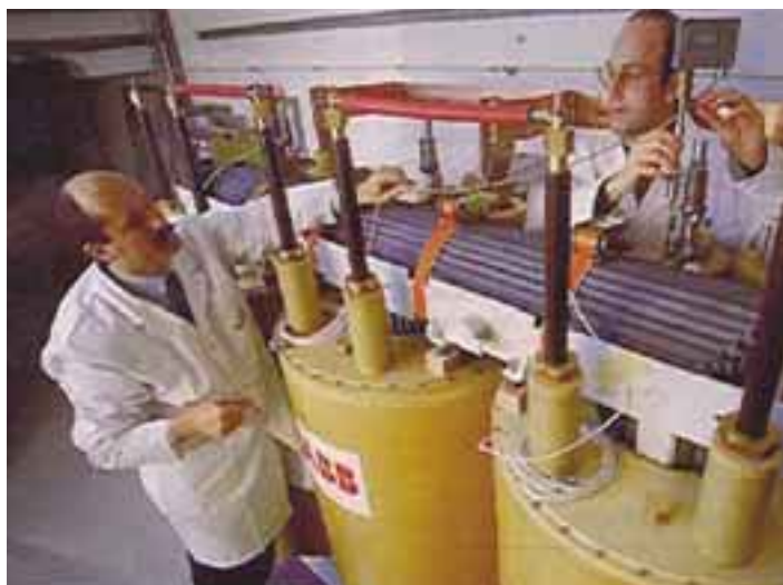
Le transformateur supraconducteur de 630 kVA développé en 1997 utilise des bandes SHT comme enroulement.
