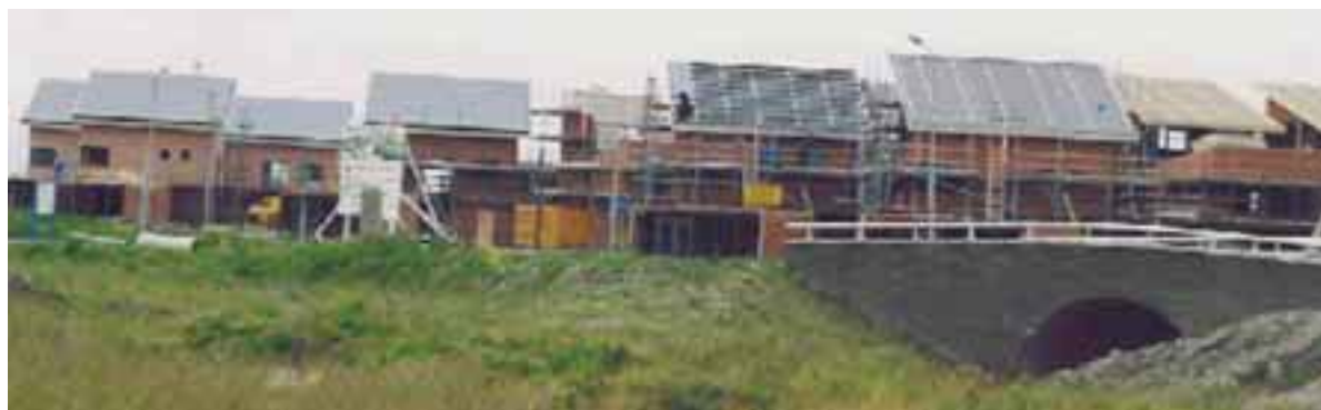
Installation AluTec, aux Pays-Bas, dans laquelle l'étanchéité de la toiture est assurée par un seul film sous les modules.
