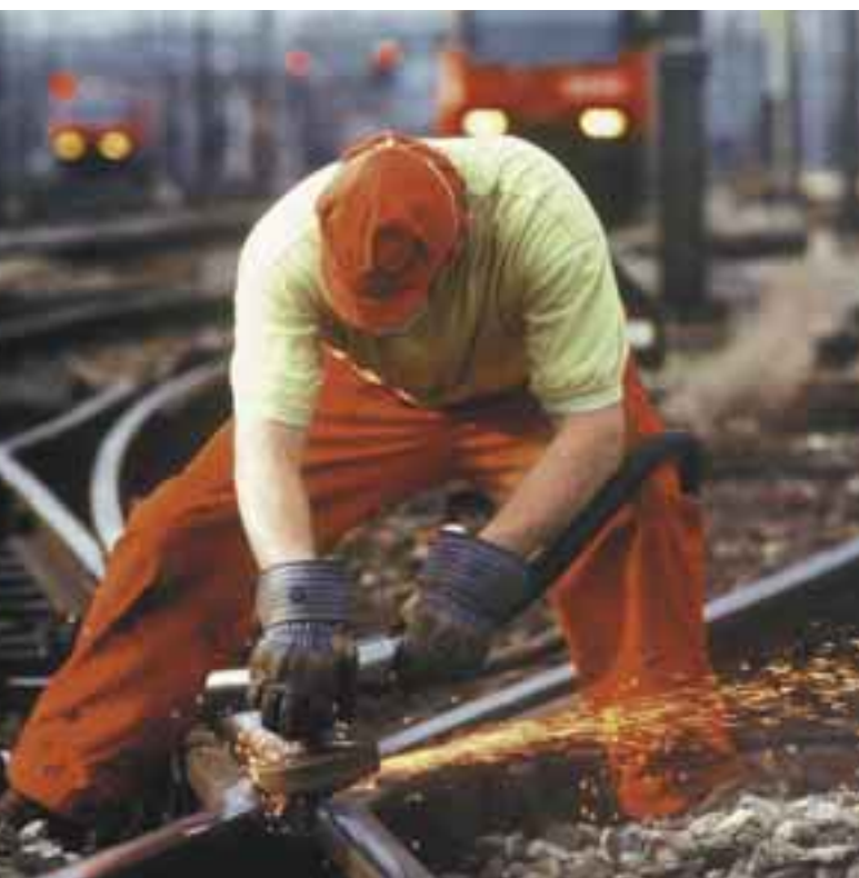
Une répartition asymétrique des avantages et des coûts engendre de l'opposition chez les personnes concernées. (Photo: CFF, Alain D. Boillat)
