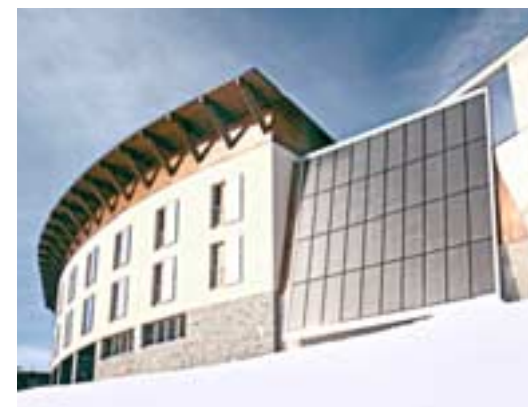
À près de 2'000 m d'altitude, l'installation combinée de l'Hôtel "Silvretta-Haus" comporte une surface de capteurs de 60 m².
