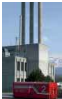
Labor Spiez: Anstelle von drei Ölkesseln erzeugen heute eine Holz- vergaseranlage und ein Ölkessel die Heizwärme.
