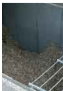
Holzschnitzel werden im unter- irdischen Silo gelagert.
