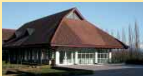
Das Studienzentrum Gerzensee setzt für Heizung und Warmwasser in erster Linie auf Wärmepumpen, welche Erdwärme und Ökostrom einsetzen.
