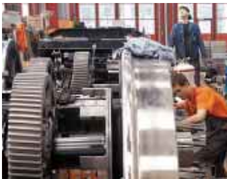
Neben dem Bahnverkehr wird der Elektrizitätsverbrauch zu einem Viertel durch stationäre Anlagen bestimmt. (Foto: BLS)
