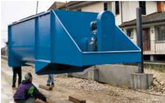
Vorbereitungen für die Montage: Einlaufseite mit angebautem Generator.
