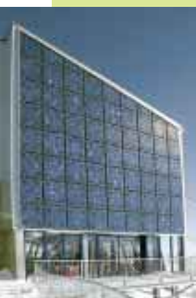
Bergstation Piz Nair mit 104 Solarmodulen: höchster Punkt des neuen Energiepfades in St. Moritz.
