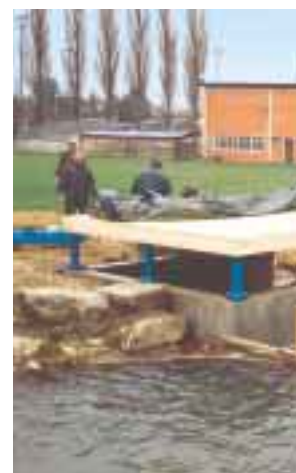
Montage der kompakten Einheit der Wasserkraftschnecke im Grützbach bei Derendingen (SO).
