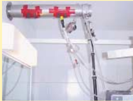
Mit einer Messkampagne wurden an ausgewählten Standorten verschiedene Parameter der Luftqualität und die Luftmengen untersucht.
