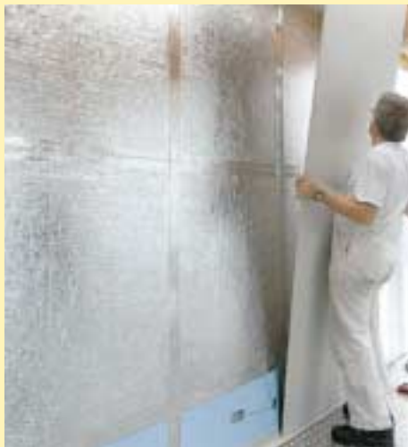
Vakuum-Isolationsplatten (VIP) stellen einen wichtigen Meilenstein bei der Entwicklung von leistungsfähigen Dämmsystemen dar.
