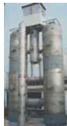
Gesamtansicht der PANDA-Behälter während der Bau-phase.
