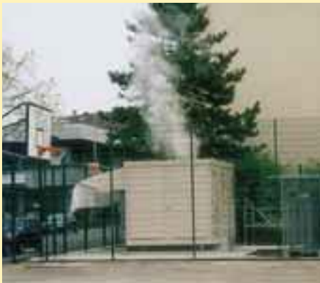
Seit November 2000 ist die PAFC-Anlage störungsfrei in Betrieb und liefert Wärme an das lokale Wärmeverbundnetz der AEB.
