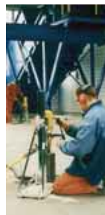
Bauarbeiten im Nasszonenbereich mit einem Teil der Förderanlagen für das angelieferte Gras.
