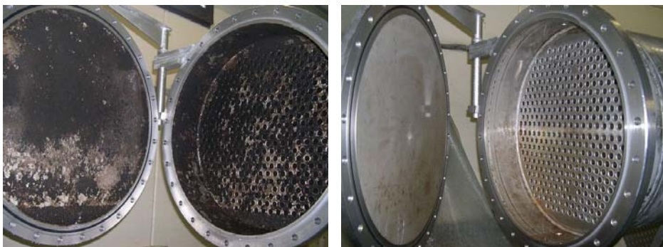
Bild 6: Wärmetauscher vor und nach der Reinigung
