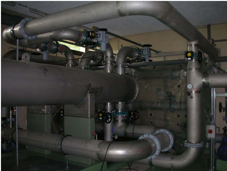
Bild 2: Wärmetauscherstation in ARA
