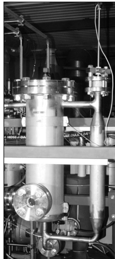
Abbildung 13: Ecoflasche mit Schauglas und integrierter Stab-Niveausonde
