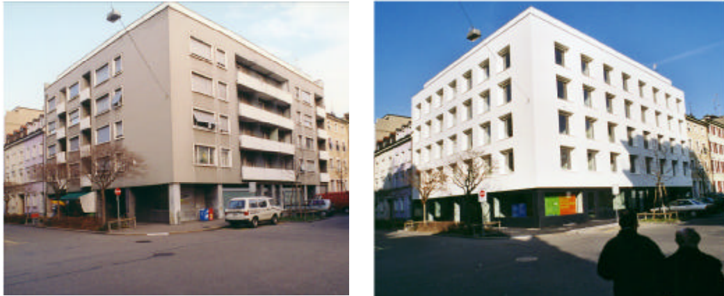
Figur 15: Sanierung MFH Müllheimerstrasse/Amerbachstrasse, Basel, Architekten: Morger Degelo AG Architekten BSA SIA, Basel, Bauherrschaft: Adimosa AG, Zürich
