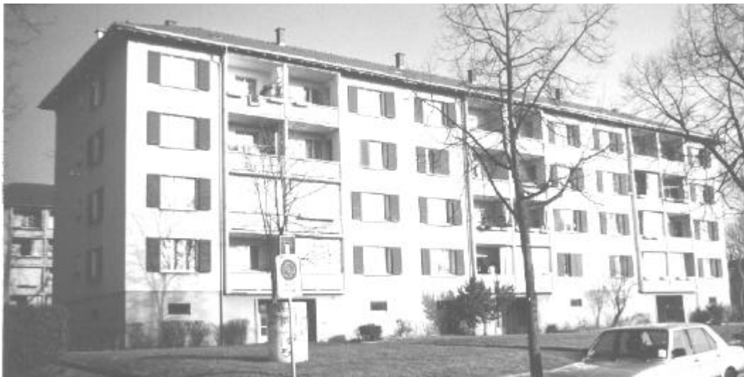
Ansicht des Objektes von Westen.
