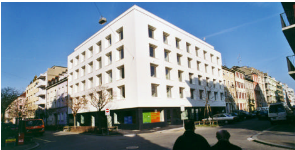
Das Gebäude vor und nach dem Eingriff.
