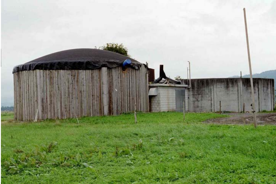
Fermenter, Technikraum und Endlager
