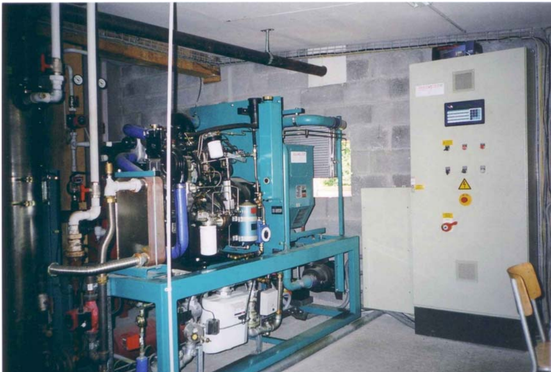
Technikraum mit BHKW und Steuerungsschrank
