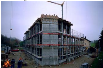
Stahlbetonskelettbau
