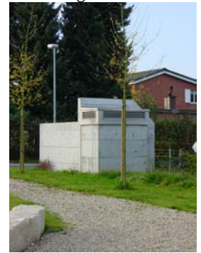
Frischluft-Ansaugeschacht
