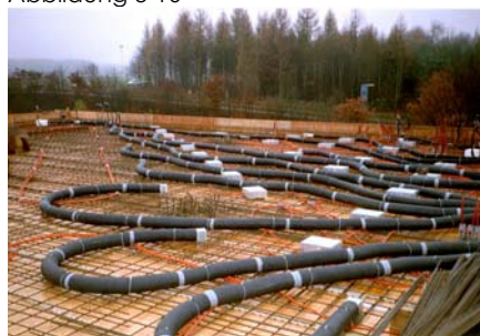
Betondecke als Verteilerebene der Lüftungsleitungen
