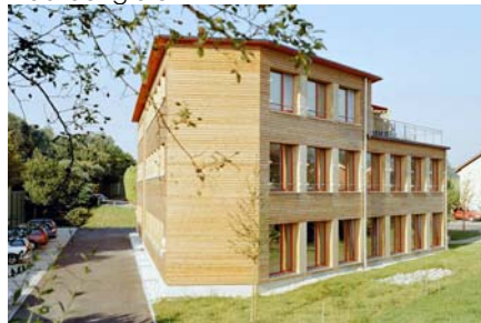
Der mit Holzelementen verkleidete Stahlbetonskelettbau
