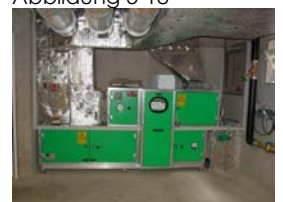
Rotationswärmetauscher
