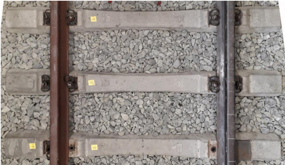
Abbildung 7-13: Betonschwellen B70 im S&V-Testgleis
