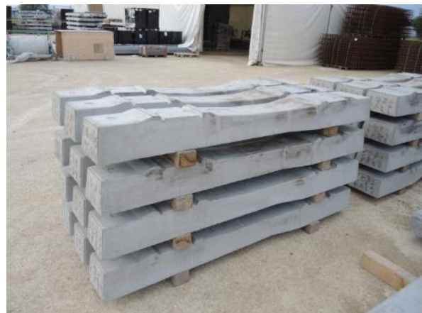
Abbildung 9-7: Lagerung der Schwellen
