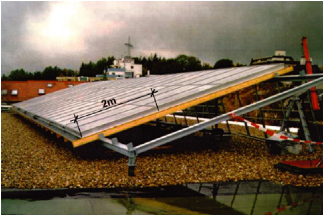
Abbildung 5: Grossflächige Kollektorfelder wie im vorliegenden Bild sollen aus Kosten- und Effizienzgründen als Parkplatzüberdeckungen eingesetzt werden, werden auch Gegenstand der Integrationsstudie sein.
