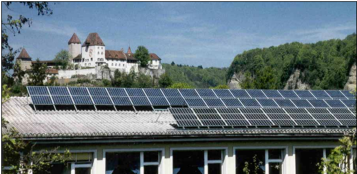
PV-Anlage Schlossmatt 3, 4, 9 und 10
