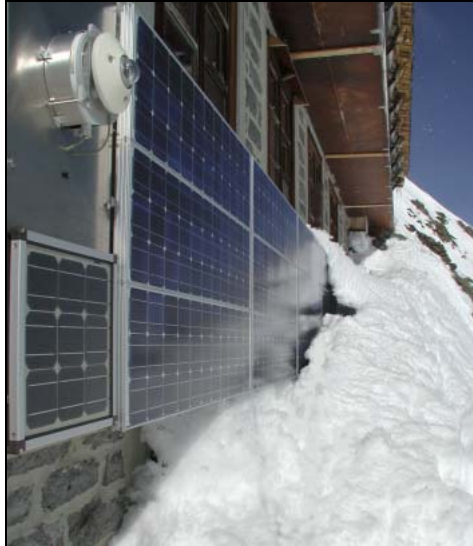
Bild 6-4: Ost-Generator aufgenommen am 07.05.2001. Die Solarmodule der Anlage Jungfrauoch sind immer horizontal zu Strängen von je 4 Module verschaltet. Bei Verschattung der hinteren Module, liefern die einzelnen Stränge kaum noch Energie.
