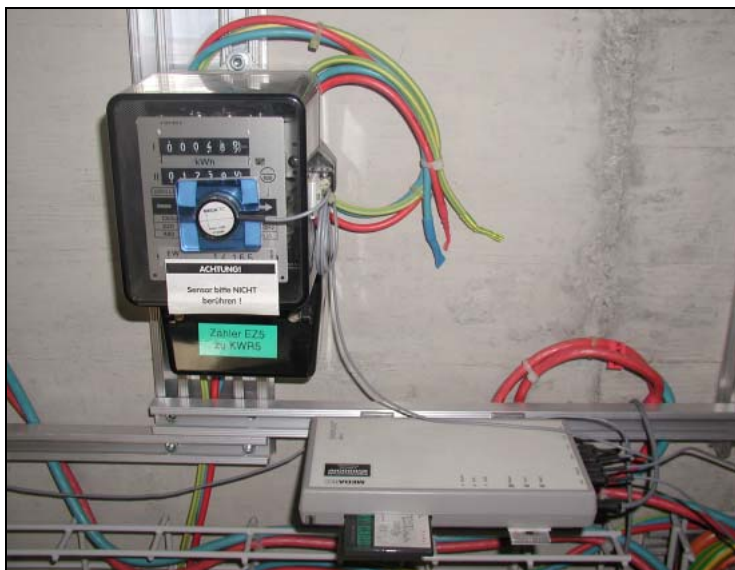
Bild 2-2: LEDAN-Datenerfassungsgerät (graues Gehäuse) mit Speicherkarte und aufgeklebten opto-elektronischen Sensors auf dem Stromzähler. Die erfassten Daten werden mit der Referenz-Strahlungsmessung der HTA Burgdorf zusammengefügt und dann ausgewertet.
