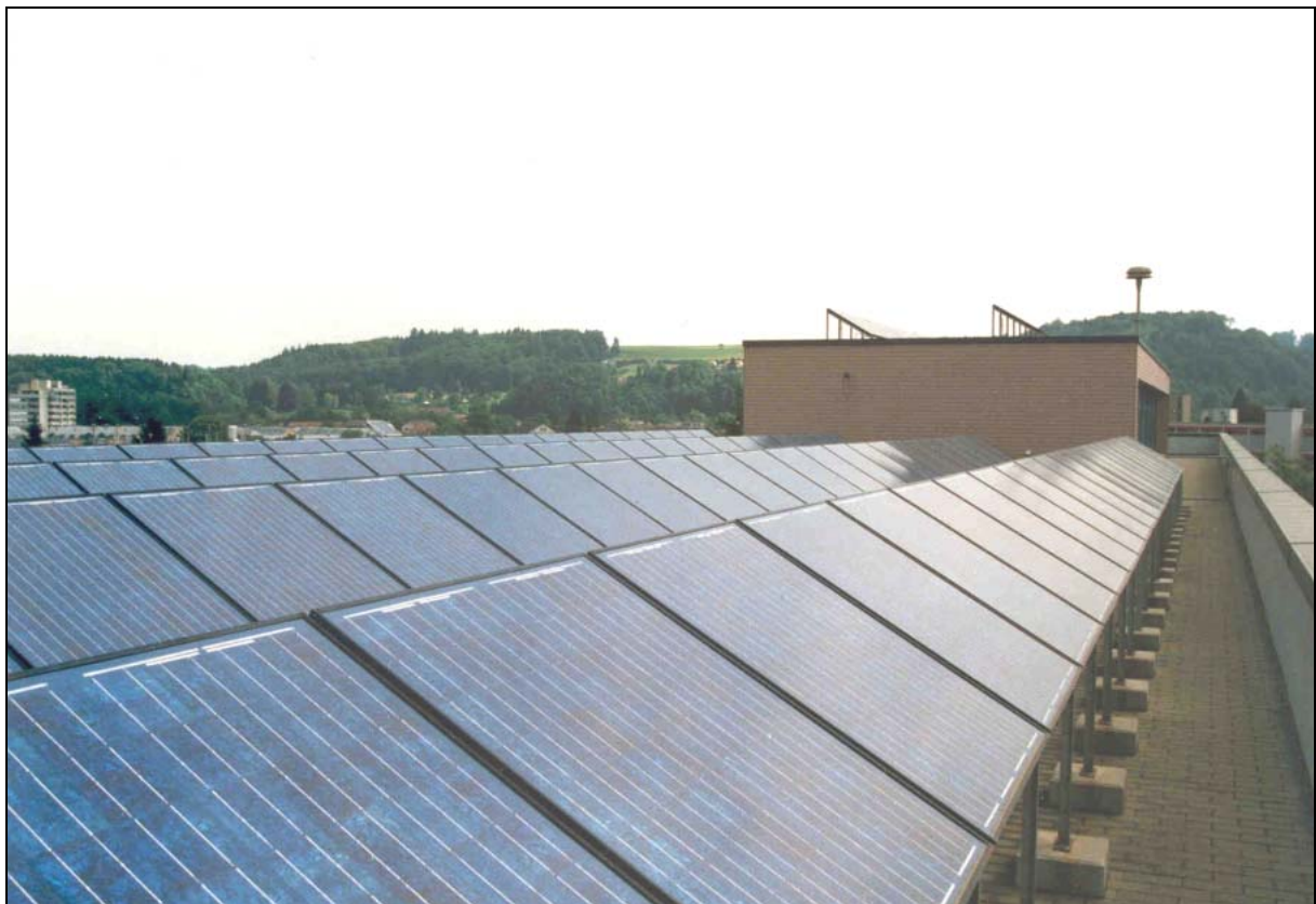
Bild 6-45: Der Solargenerator der Localnet AG Gsteighof ist auf zwei Dachflächen verteilt. Ein Teil befindet sich noch auf dem kleinen Lift- und Schulraumgebäude im Hintergrund.
