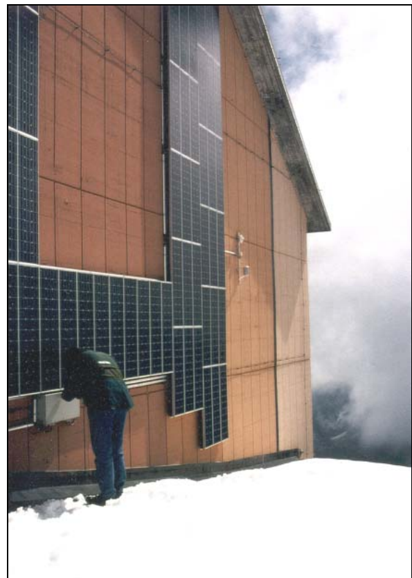
Bild 6-7: In schneereichen Wintern können die unteren Module und der Feldanschlusskasten durch Schnee bedeckt werden.
