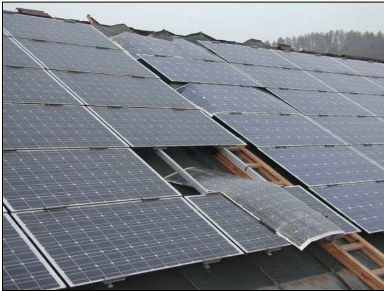
Bild 5-1: PV-Anlage Alterspflegeheim, Burgdorf nach gelöschtem Brand durch die Feuerwehr. Bei dem Einsatz wurden mehrere Module durch Betreten zerstört. Ein Feuerwehrmann erlitt dabei einen Stromschlag, jedoch glücklicherweise ohne weitere Folgen.
