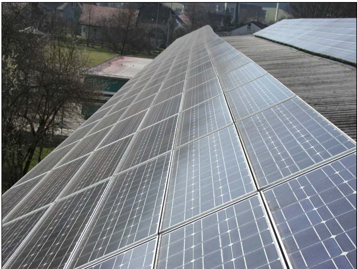
Bild 6-43: Der Solargenerator der Anlage Schlossmatt 8 besteht aus dem vorderen Teil (60 Module) der dargestellten Fläche.
