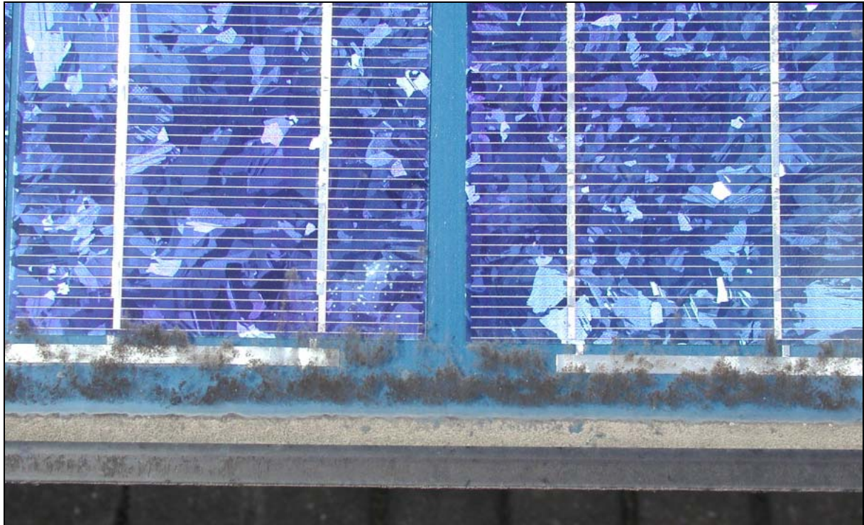
Bild 6-47: Obwohl die Module gerahmt sind, beeinflusst der sich im Laufe der Jahre entwickelnde Schmutzstreifen an den unteren Modulrändern die Zellen und damit den Anlagenenertrag kaum.
