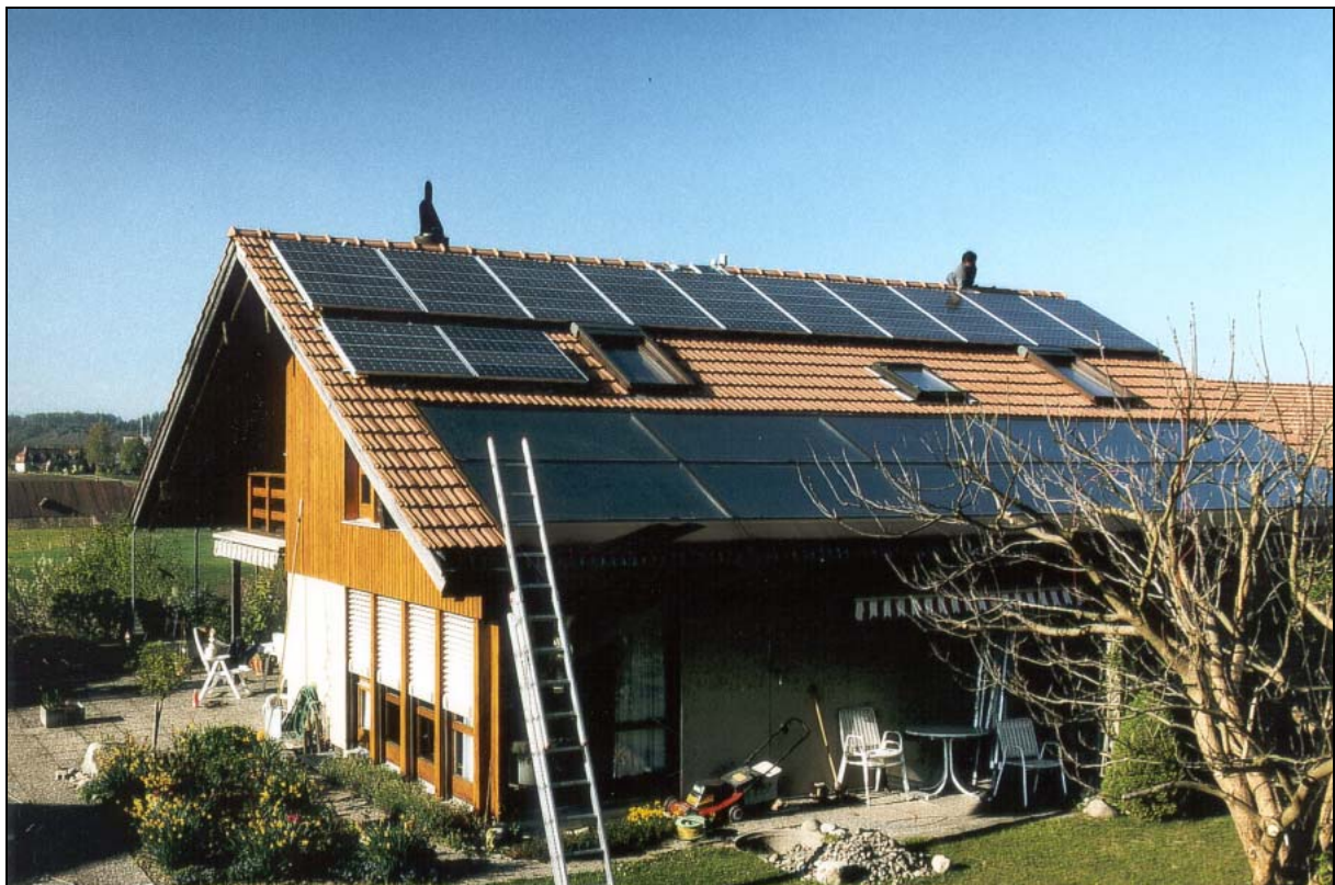
Bild 6-38: Der Solargenerator besteht aus dem oberen Feld unterhalb des Dachgiebels. Darunter befindet sich noch der Generator einer autonomen PV-Anlage und die Kollektoren einer Warmwasseranlage.
