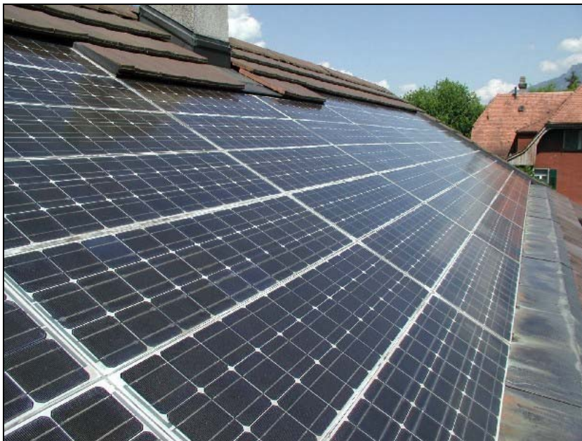
Bild 4-10: Dachintegrierte PV-Anlage Burn. Die Hinterlüftung der Module ist schlecht. Dies sollte jedoch nicht die Ursache für den schlechten Zustand des Solargenerators sein.
