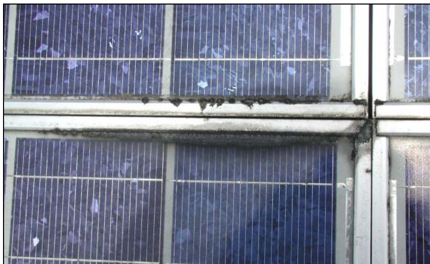
Bild 6-35: Im Laufe der Zeit heraustretende Dichtungsmasse an unterer und oberer Modulkante. Leichte Verschattungen der Zellen durch die Dichtungsmasse können dabei auftreten.
