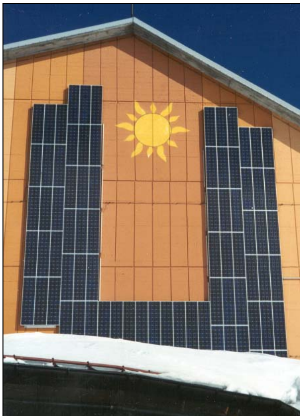
Bild 6-6: Der Solargenerator der Anlage Birg. Im Sommerhalbjahr wird der obere Teil des Generators vormittags durch das Dach verschattet.
