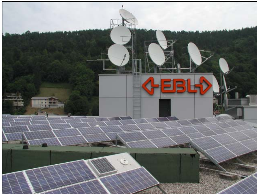
Bild 6-31: Bei der PV-Anlage EBL Liestal haben sich nach der Dachsanierung einige Änderungen ergeben. Der Solar-generator ist um ein Modul von 18,56 kWp auf 18,51 kWp verkleinert worden. Auf dem Liftgebäude wurden mehrere Parabolantennen installiert, die den Solar-generator am Morgen mehr verschatten. Auf dem Dach wurde ein grosser Träger plaziert, dadurch musste ein Teil des Solargenerators weiter in die Nähe des Liftgebäudes verschoben werden.
