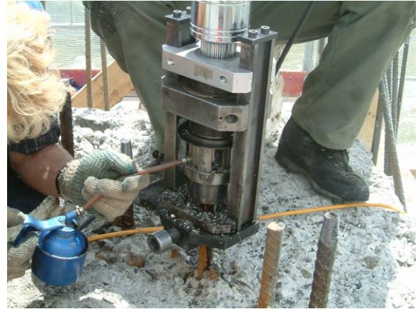
Figur 10: Schneiden der Gewinde auf die Armierungseisen
