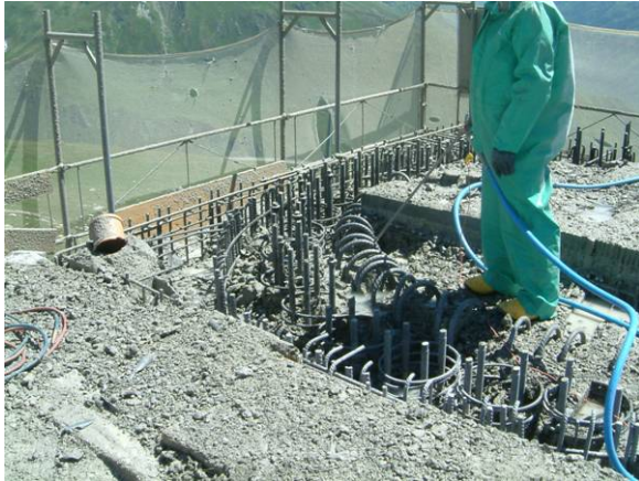
Figur 9: Abtragen von Beton mit dem Hydrojettverfahren
