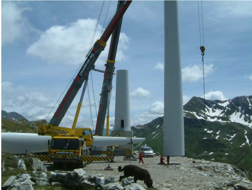
Figur 5: Demontage der Lagerwey-Anlage
