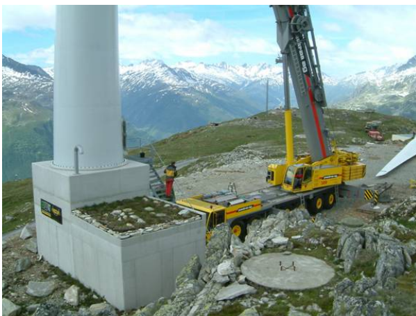
Figur 7: Schwerkraftfundament und Pneukran bei der Demontage der Lagerwey -Anlage
