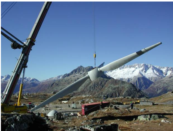
Figur 16: Rotormontage mit nur einem Pneukran
