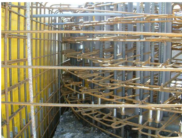
Figur 13: Bolzenkorb Armierung und Aussenschalung vor dem Einbringen des Betons
