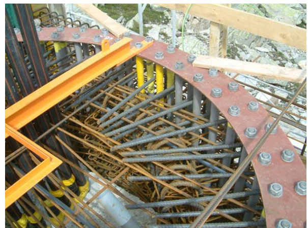
Figur 12: Bolzenkorb integriert in der Verlängerung der Armierungseisen
