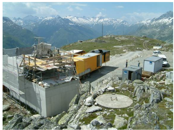
Figur 8: Installationen für das Hydrojetten
