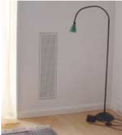
Figur 6-2: Innenansicht der Luftboxe resp. des feinen Eintrittsgitters
