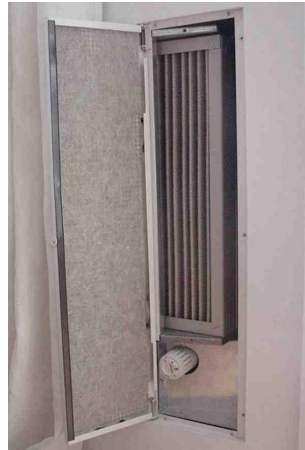
Figur 6-3: Ansicht in die Lüftungsboxe von der Raum-Innenseite, bei geöffnetem Deckel
