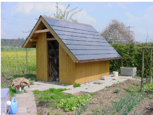
Fig. 5: Gartenhaus mit PV/T-Schiefer
