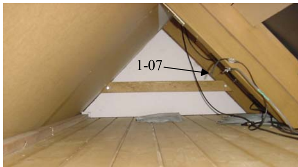
Fig. 14: Dachgiebelraum mit Thermoelement-Temperaturfühler
