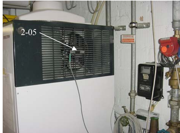
Fig. 15: Wärmepumpen-Luftaustritt mit Thermoelement-Temperaturfühler
