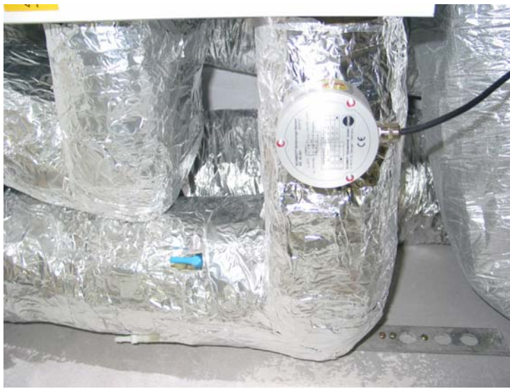
Abbildung 20: Strömungssensor für die Luftgeschwindigkeit FOL im 2. Obergeschoss.
