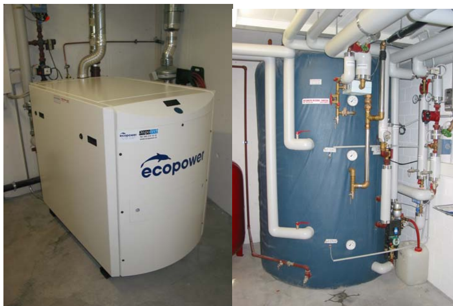
Abbildung 13: Blockheizkraftwerk und Speicher im Technikraum 1 des Untergeschosses.
