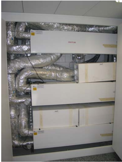
Abbildung 14: Drei Wohnungslüftungsgeräte mit Austauschcassetten im Schrankeinbau des 2. Obergeschosses.
