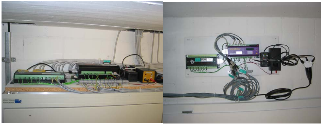
Abbildung 19: Datenlogger „Technik“ und „BHKW“ der HTA Luzern im Untergeschoss.
