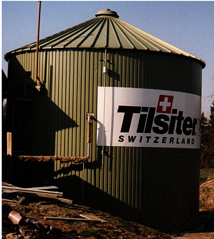
Hauptfermenter der Biogasanlage auf dem Holzhof
