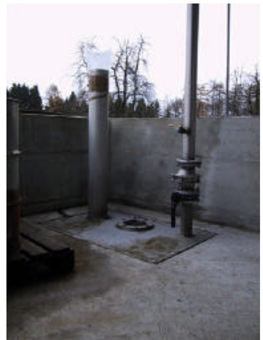
Abdichtung Nachgärer mit Gasfassung
