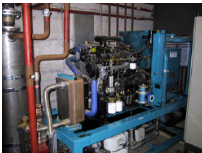
Zündstrahl BHKW Marke Schnell
