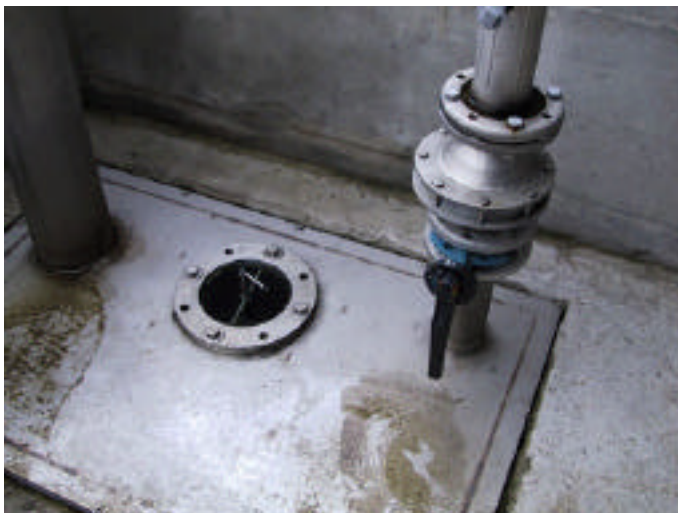
Gasfassung Nachgärer mit Absperrmatur und Flammensperre
