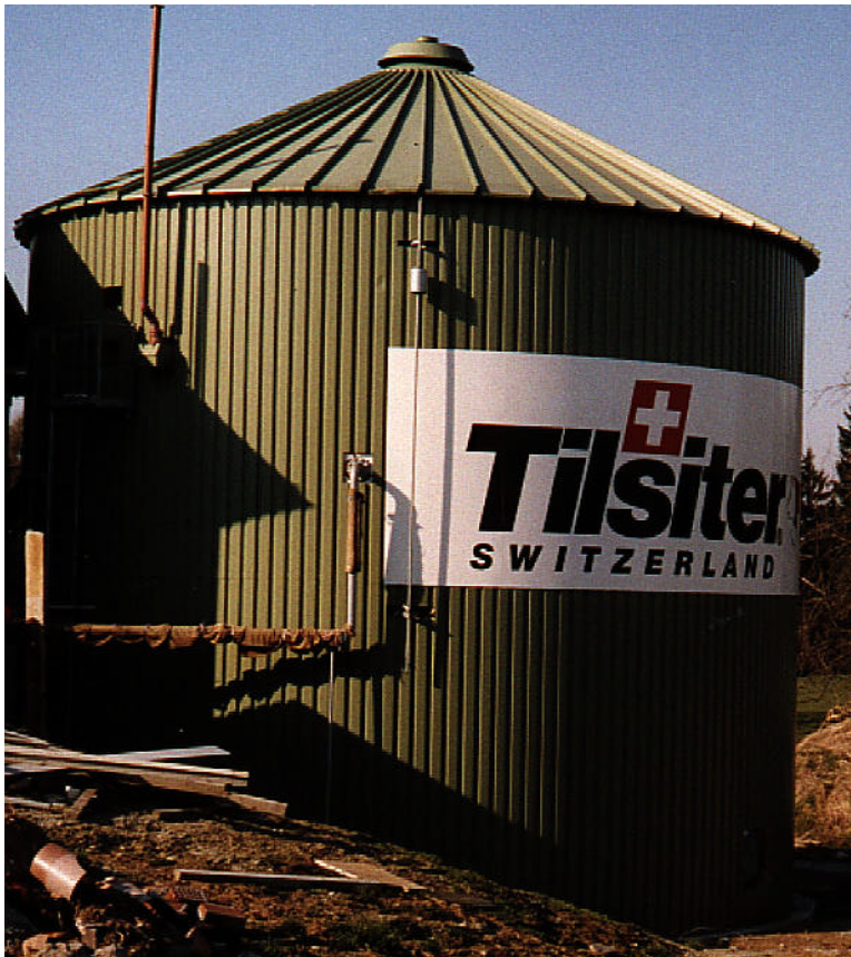
Hauptfermenter der Biogasanlage auf dem Holzhof
