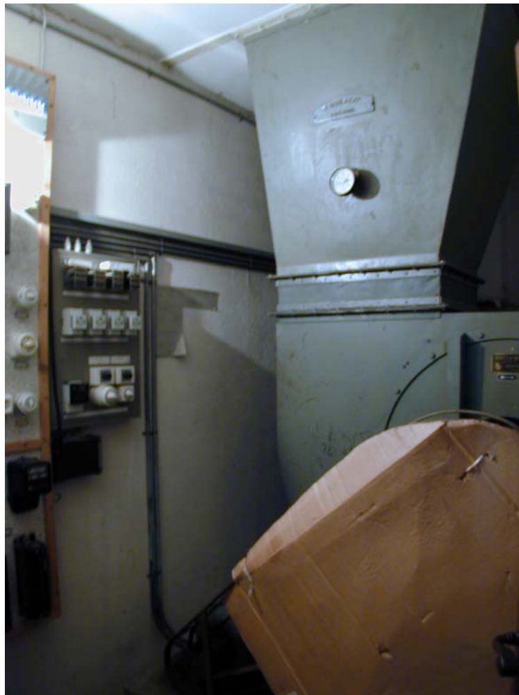
Abb. 2: Steuertableau, Ventilator (Pulliabdeckung aus Karton) und Zuluftkanäle
