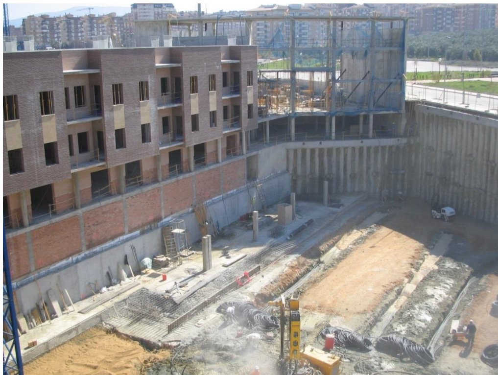
Execution works of 45 geothermal exchangers (at 126 m depth) for HVAC of the Residencia Maria Santísima de la Caridad y Consolación in Jaén, Andalucía. (Photo courtesy of PILOSUR GEOTERMIA)
