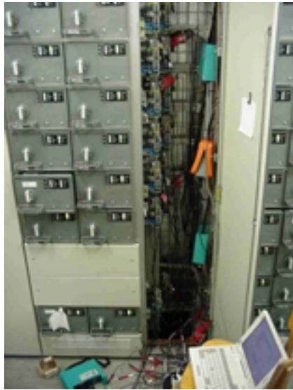
Figur 1: Messgeräteinsatz in den Niederspannungsverteilschränken zur Erfassung des Energieverbrauchs der elektrischen Antriebe
