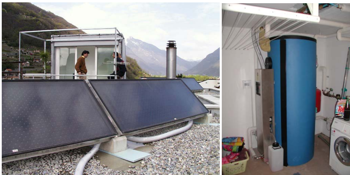
Fig. 3.7 Sistema solare compatto per l'acqua calda. Sinistra: collettori solari termici sul tetto. Destra: accumulatore per lo stoccaggio d'acqua calda in lavanderia.
