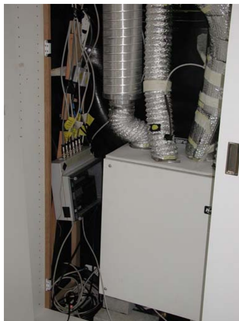
Fig. 4.2 Datalogger usato per rilevare con passo orario le temperature dei flussi d'aria, i tempi di funzionamento dei ventilatori e della resistenza elettrica per il riscaldamento dell'aria fresca.
