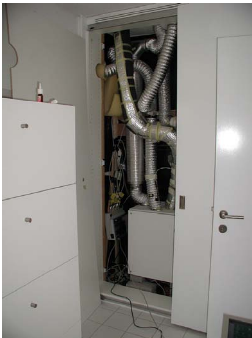
Fig. 3.6 Sinistra: sistema di ventilazione a doppio flusso con recupero di calore. Destra: immissione d'aria fresca tramite bocchetta in una camera.
