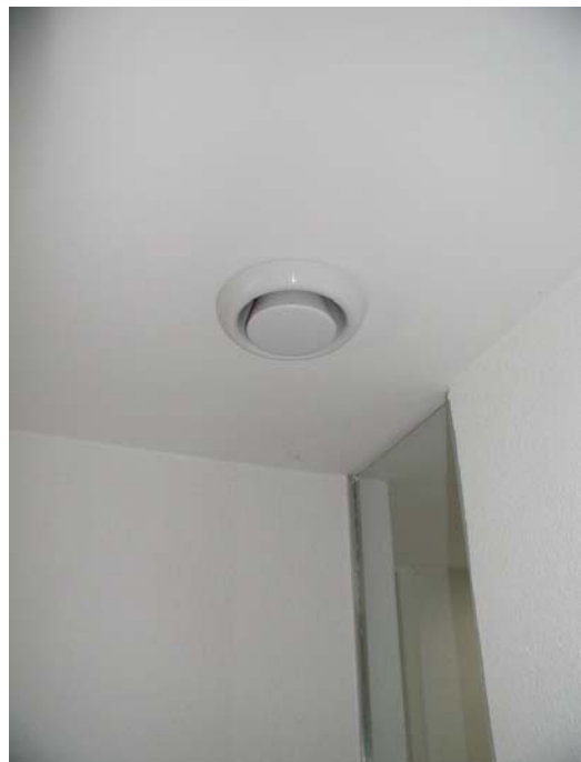
Fig. 3.6 Sinistra: sistema di ventilazione a doppio flusso con recupero di calore. Destra: immissione d'aria fresca tramite bocchetta in una camera.
