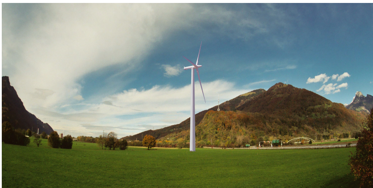
Abb. 56: Fotomontage einer Einzelanlage am Standort der Windmessung Niederurnen Leistung 1'300 kW, Turmhöhe 68 m, Rotorblatt 31 m, Gesamthöhe 99 m
