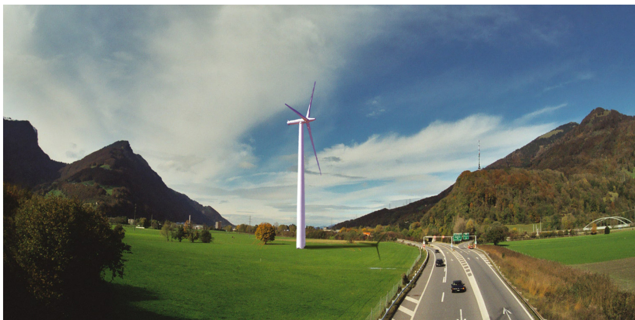
Abb. 57: Fotomontage einer Einzelanlage am Standort der Windmessung Niederurnen Leistung 1'300 kW, Turmhöhe 68 m, Rotorblatt 31 m, Gesamthöhe 99 m
