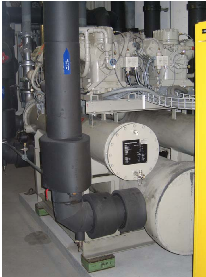
Abbildung 6: Kompressions-Kältemaschine
