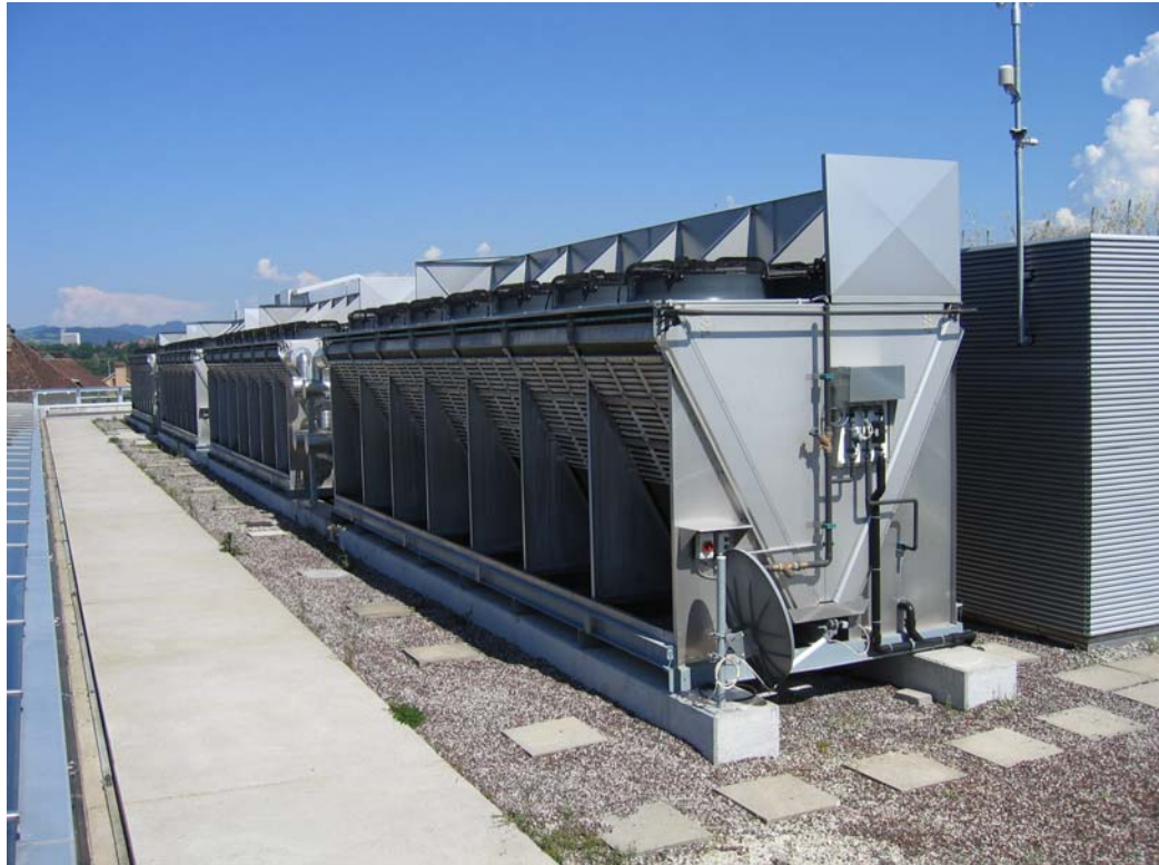
Abbildung 7: Hybridrückkühler auf dem Dach des Aufnahmegebäudes
