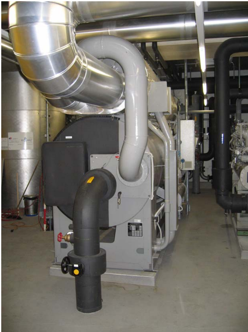
Abbildung 5: Absorptionskältemaschinen Bahnhof Bern
