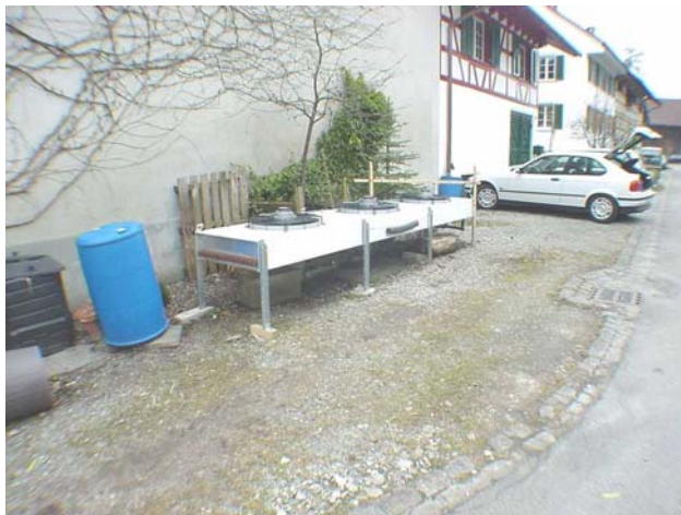
Abb. 2.1 Luftkühler der Anlage in Waltalingen
