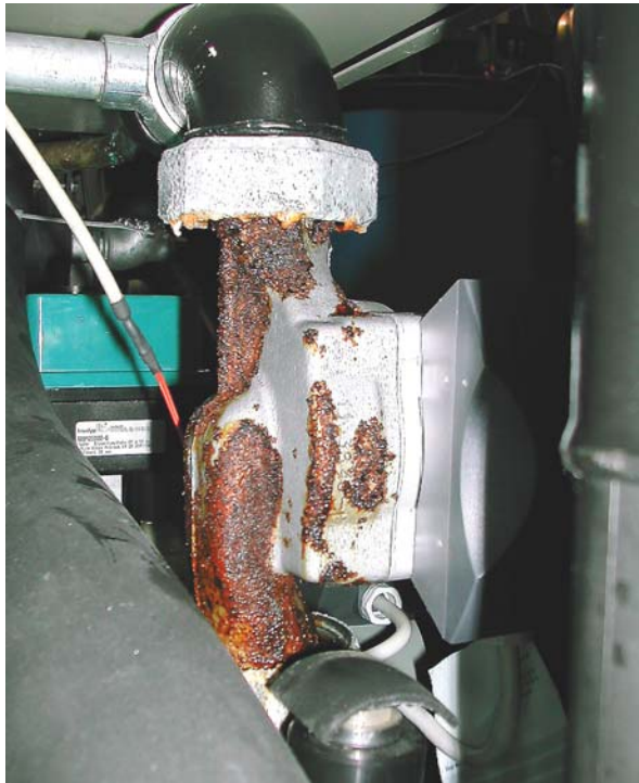
Abb. 8.2 Von Temper angegriffene Umwälzpumpe (nach ca. 2 Monaten Betrieb)
