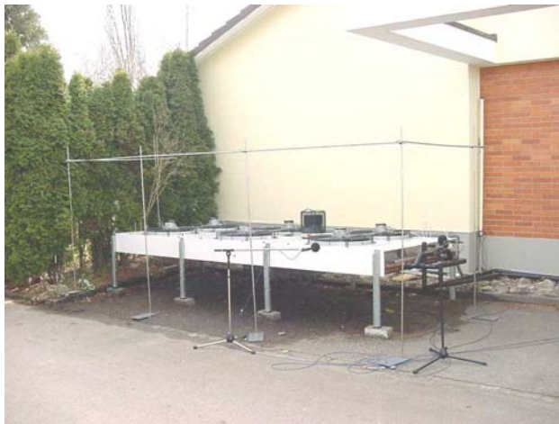
Abb. 7.6 Verdampfer der Anlage in Münsingen
