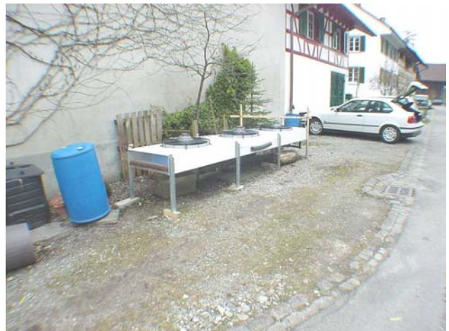
Abb. 7.7 Verdampfer der Anlage in Waltalingen
