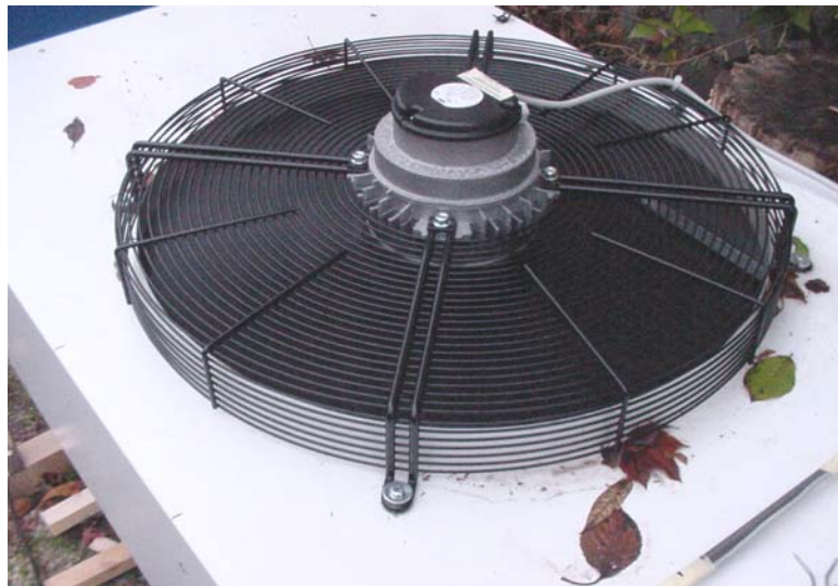
Abb. 3.2 Ventilator des Luftkühlers in Waltalingen
