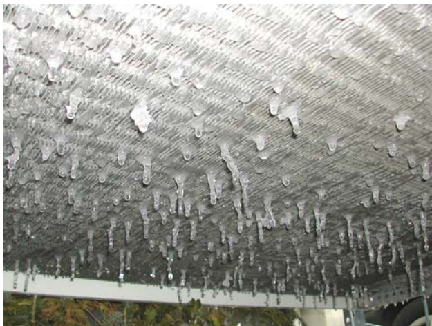
Abb. 8.1 vereister Luftkühler kurz vor dem Abtauen
