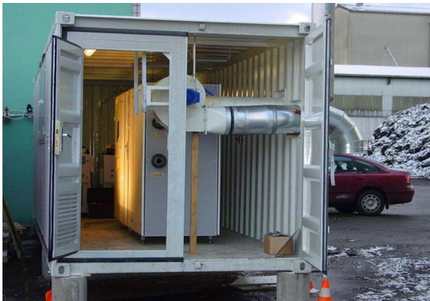
Bild 2 Mikroturbine und Kompressor im Spezialcontainer.
