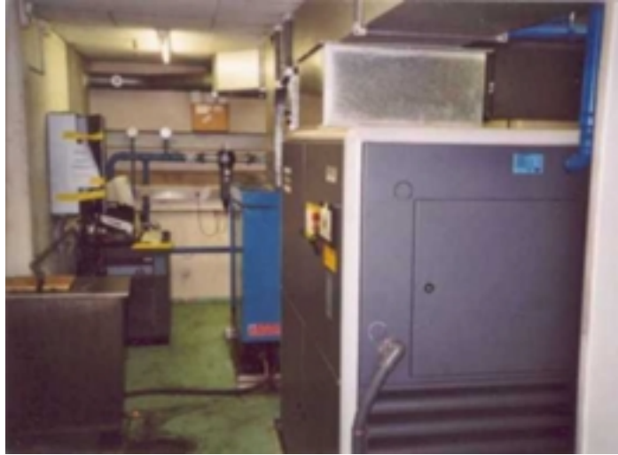
Abb. 1) Im Vordergrund der neue 30-kW-Schraubenkompressor mit 6500 Jahresbetriebsstunden, dahinter der alte Reservekompressor, links daneben der Kältetrockner und darauf die Leistungsmessung.
