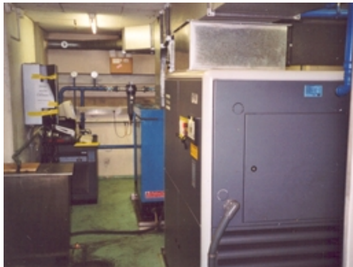
Abb. 1) Im Vordergrund der neue 30 kW Schraubenkompressor mit 6500 Jahresbetriebsstunden, dahinter der alte Reservekompressor, links daneben der Kältetrockner und darauf die Leistungsmessung (Foto Gloor).
