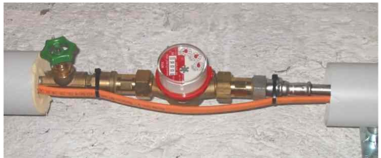
Bild 8 Heizband-Ausführungsdetails Abschluss, Wasserzähler
