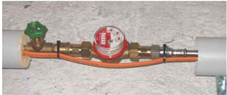
Bild 4 Heizband-Ausführungs-detail Wasserzähler: nicht isoliert!
