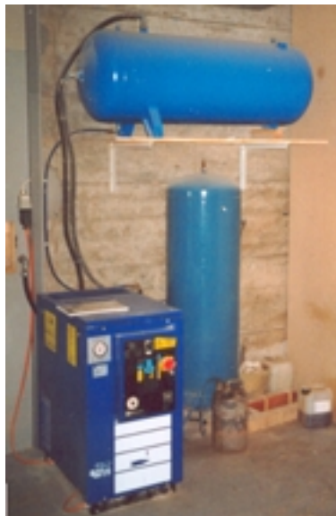
Abb. 2) 5,5 kW Schraubenkompressors und 2 Druckluftbehälter mit je 270 Liter Inhalt
