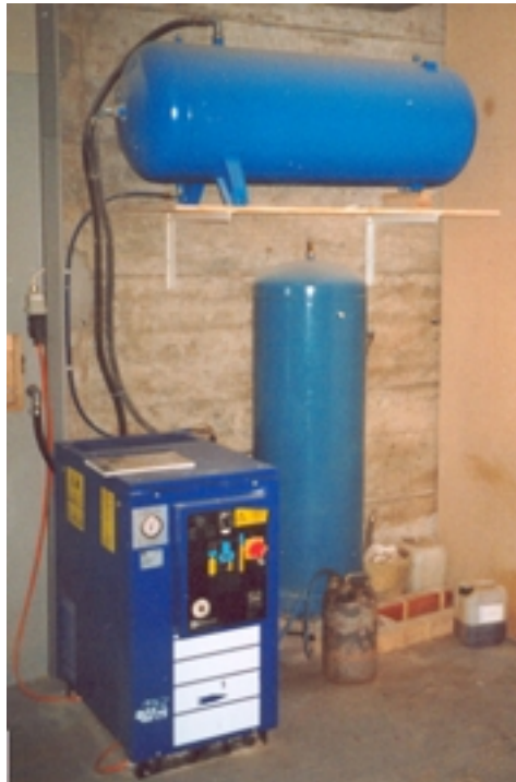
Abbildung 1) 5,5-kW-Schraubenkompressor und zwei Druckluftbehälter mit je 270 Liter Inhalt.
