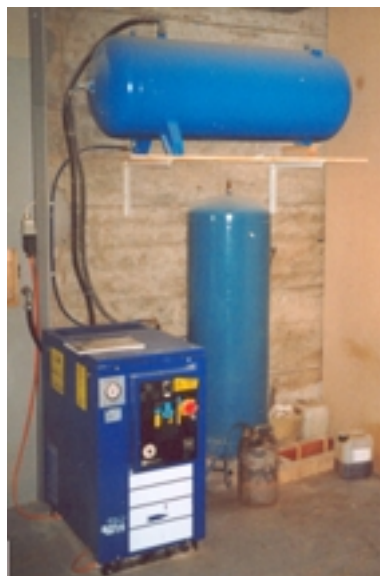
Abb. 1) 5.5 kW Schraubenkompressors und 2 Druckluftbehälter mit je 270 Liter Inhalt (Foto Gloor)
