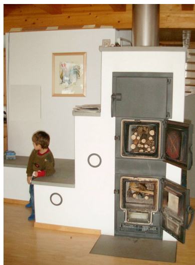
Abb. 5.2 Holz-Speicherofen im Einfamilienhaus Nottwil; Beschickter Speicherofen (Füllschacht über zwei Türen hoch)
