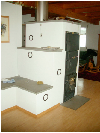
Abb. 5.7: Speicherofen, Sicht auf Temperaturfühler Sitzbank, Ofenwand (Mitte über Sims) und Ofentüren
