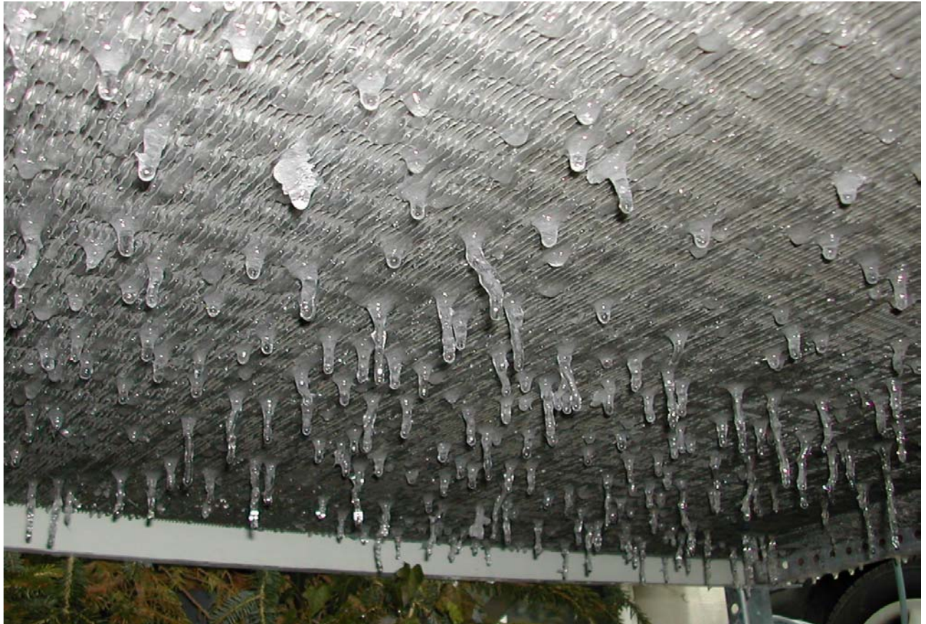
Abbildung 43: Vereister Luftkühler von unten
