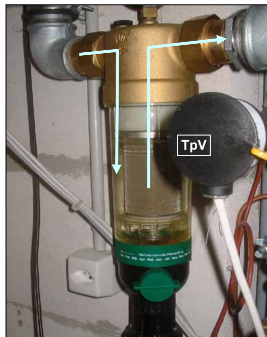
Automatischer rückspülbarer Sandfilter, der nachträglich eingebaut wurde.
